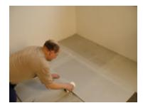
El aislante lateral no requiere características especiales (ejemplo: espuma flexible espesor >5mm), siempre que el fabricante del mismo indique que este material no es incompatible con calefacción radiante.
